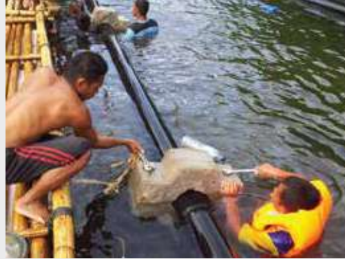
Instalasi Pipa Bawah Laut Kota Mamuju, Pulau Karampung, Sulawesi Barat
